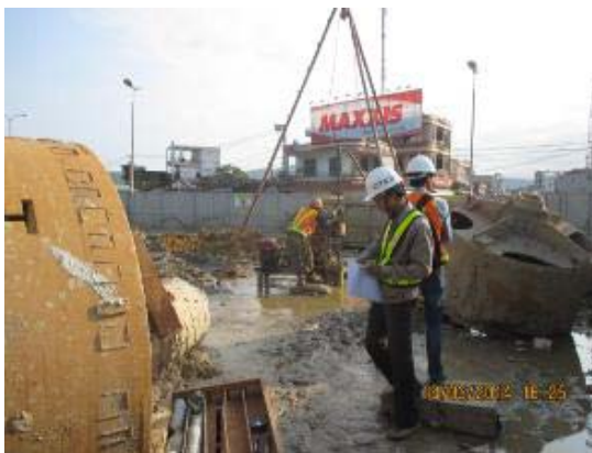
Khoan địa chất bổ sung tại trụ tháp
